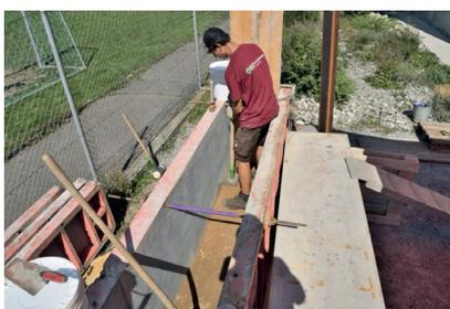
Schicht um Schicht einbauen und von Hand stampfen
